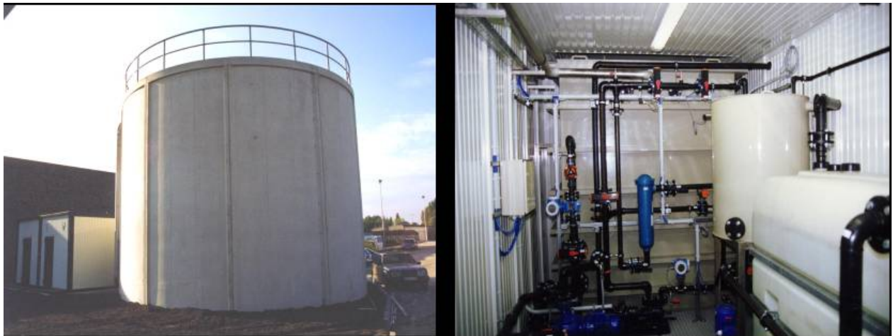
Abbildung 4 Ansicht des Bioreaktors (linkes Bild) und der Membranfiltrationseinheit (rechtes Bild) der Rhein-Main Biokompost
